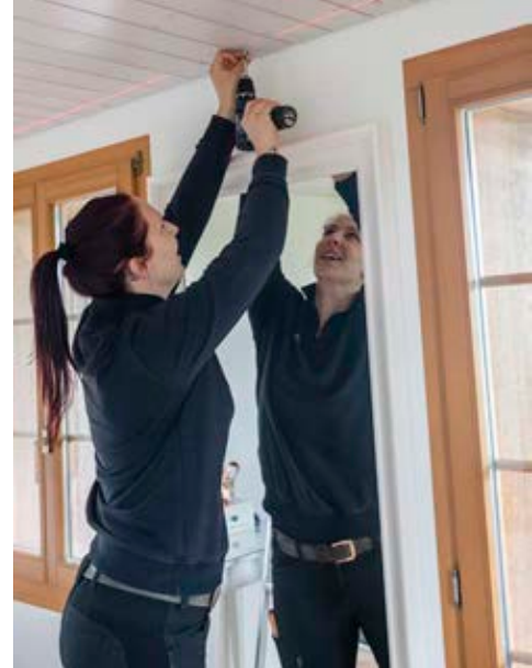
Simone Lanz installiert die Aufhänger für die Vorhangschiene mit Hilfe des Laser-Lots.
